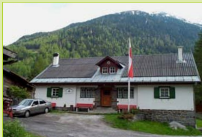
Die Talherberge kann direkt angefahren werden
