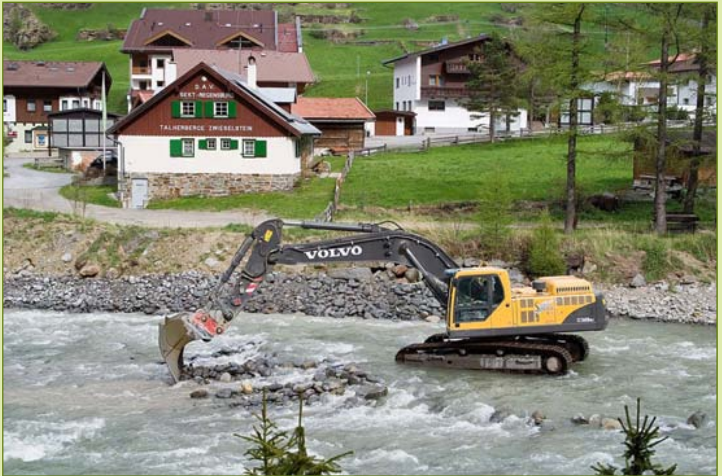
Flussbauarbeiten an der Öztaler Ache
