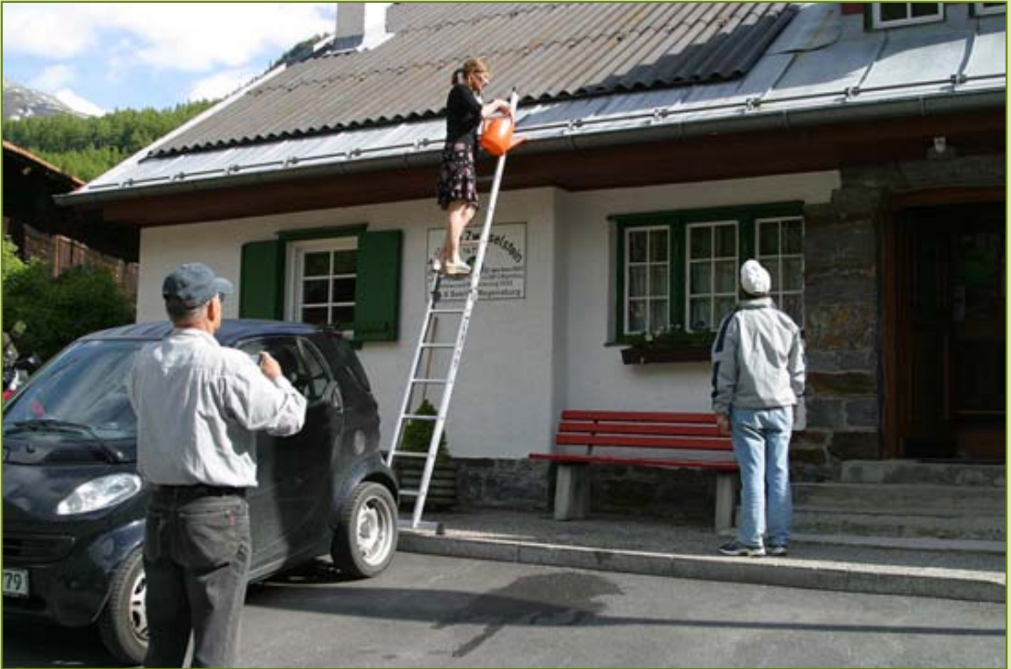
Instandsetzungsarbeiten an der Talherberge Zwieselstein: Regenrinnen-Dichtheitsprüfung
